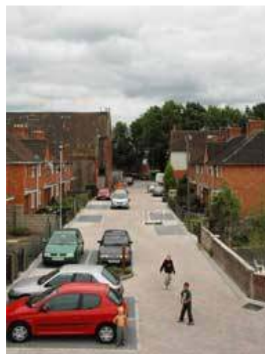
Nach der Umgestaltung sind alle Verkehrsteilnehmenden gleichberechtigt. Die Parkierung ermöglicht kein schnelles Fahren mehr. Die Strasse eignet sich wieder als Spiel und Aufenthaltsraum für Kinder.
